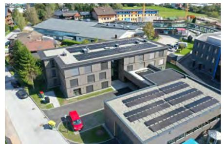
Einen Großteil des benötigten Stroms erzeugt die effiziente Photovoltaikanlage auf dem Gebäudedach.
