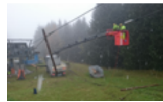
Bei Seilsanierungsarbeiten am Hirschkogel-Express wird von den Mitarbeitern eine Seilklemmbanke und ein Hilfsseil montiert, um das Förderseil zu entspannen. Im Frühsommer kann es am Berg schon mal überraschend winterlich werden.
