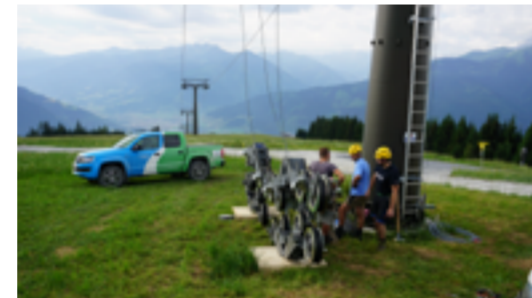
Die Betriebsgruppe Areit-Zellerberg mit Stefan Pausch, Matthias Moßhammer und einem Mitarbeiter des Seilbahnherstellers führt an der Glocknerbahn Revisionsarbeiten und die Überprüfung einer Rollenbatterie durch.
