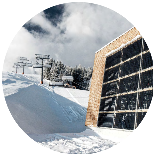
Glocknerbahn mit integrierten Photovoltaikpaneelen
