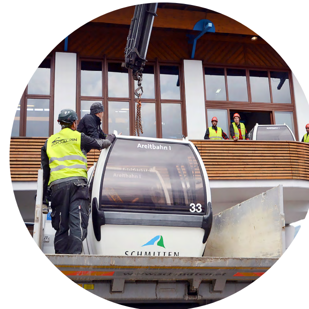
Abbau der alten Areitbahn
