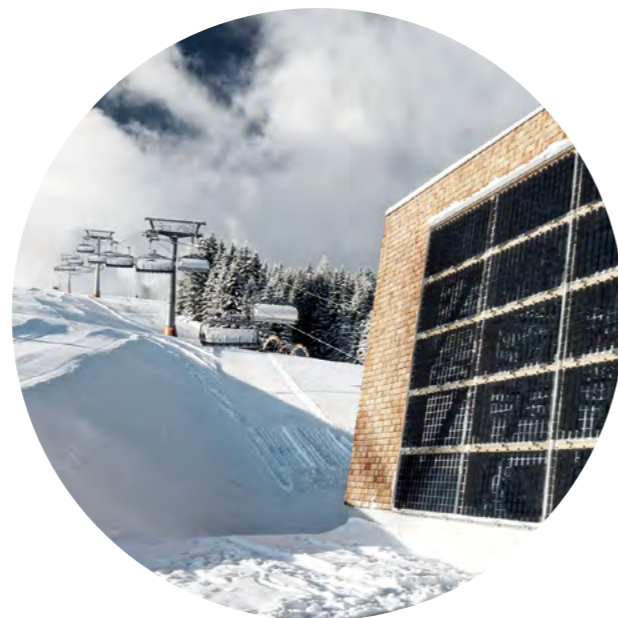
Glocknerbahn mit integrierten Photovoltaikpaneelen
