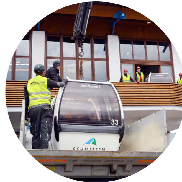
Abbau der alten Areitbahn
